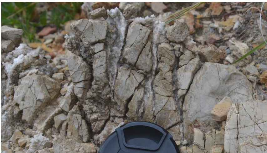
Fig. 23. Calizas arenosas muy fracturadas del Triásico con yeso cristalizado entre sus grietas.
