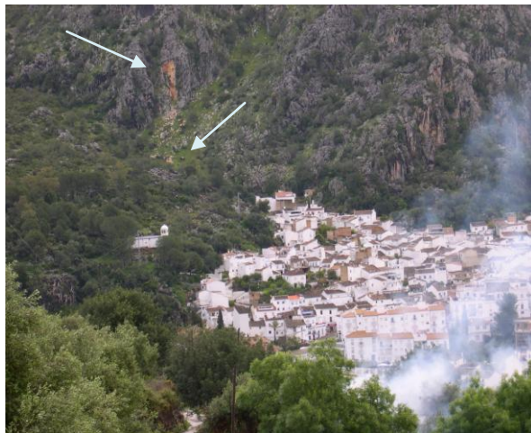
Fig. 13. Zona de desprendimiento de rocas. Ubrique
